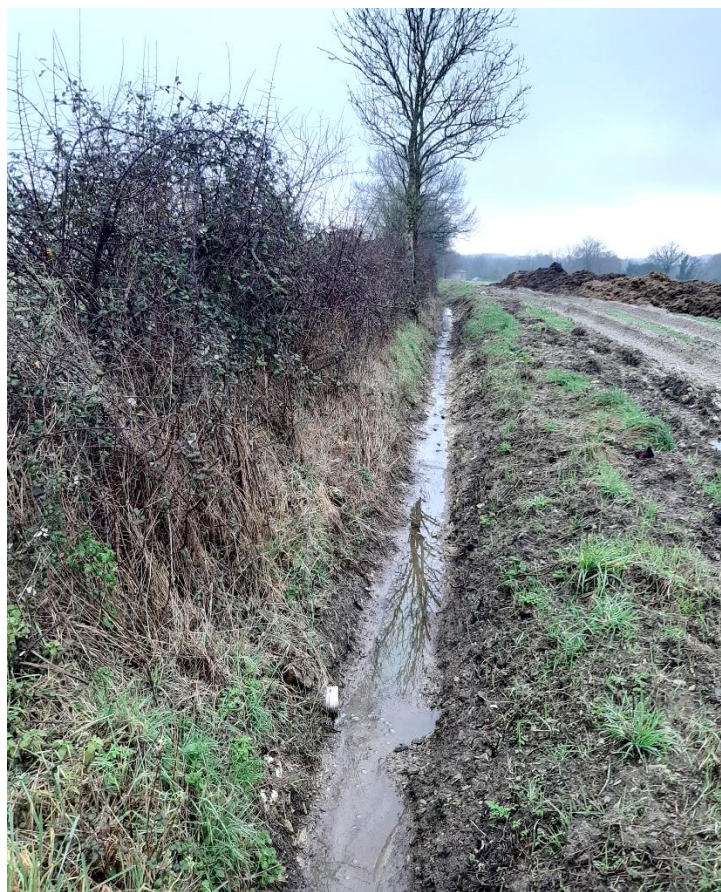
Vue E : Vue sur le fossé de récupération des eaux pluviales du bâtiment
