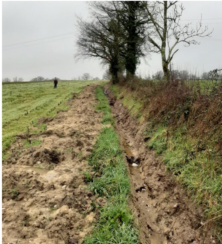
Fossé de récupération des eaux pluviales du site NCA environnement, Janvier 2019
